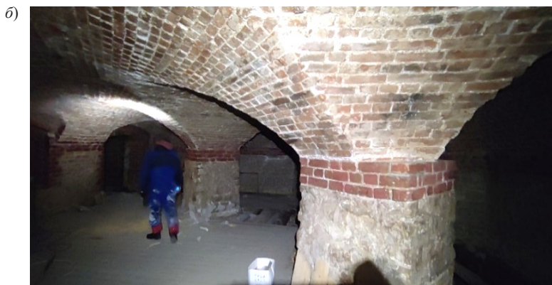
Рис. 1, окончание . Гостиный двор, сводчатые перекрытия цокольного этажа: б – комбинированный свод
