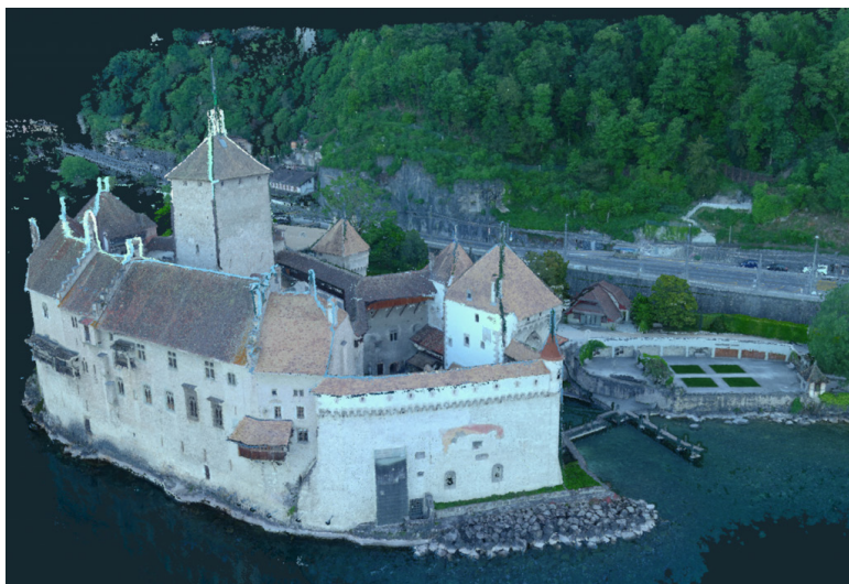
Рис. 2. Результат воздушного сканирования с помощью БПЛА Шильонского замка в Швейцарии [2]
