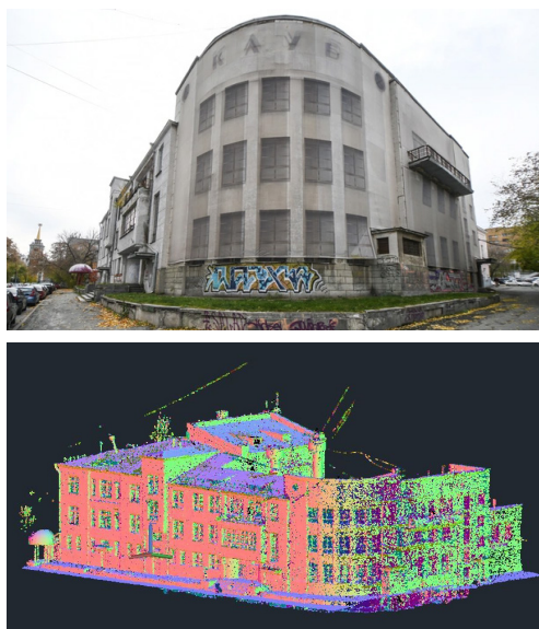
Рис. 1. Здание ДК Свердлова в Екатеринбурге, ул. Володарского, 9 (фото А. Устюжанина / e1.ru) и облако точек (получено А. С. Романовым с помощью сканера и ПО FARO)
