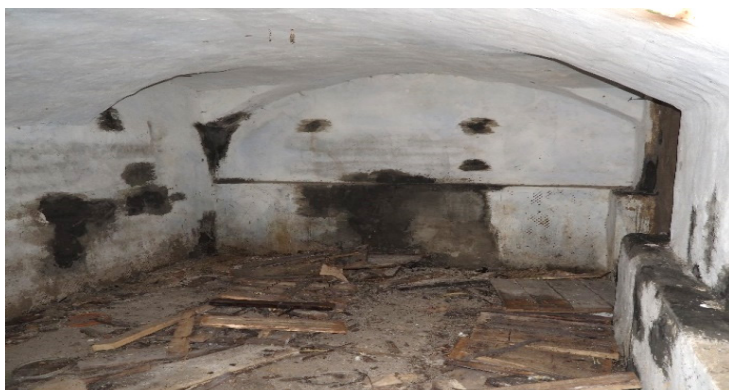
Рис. 1, начало. Гостинный двор, сводчатые перекрытия цокольного этажа: а – цилиндрический свод с распалубками
